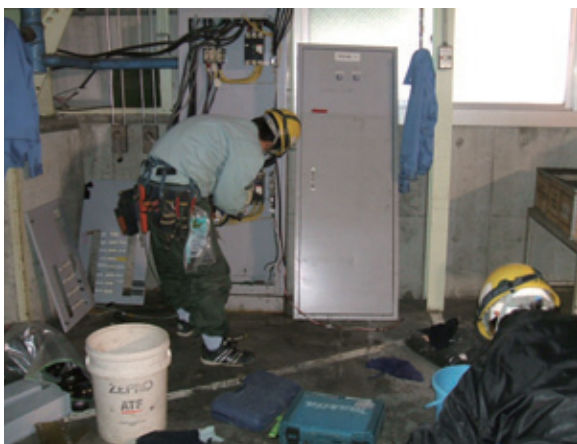
復旧作業の様子
