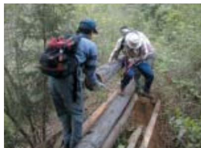
丸木橋架け替え作業
