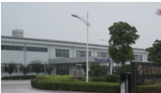
Hitachi Cable (Suzhou) Co., Ltd.
